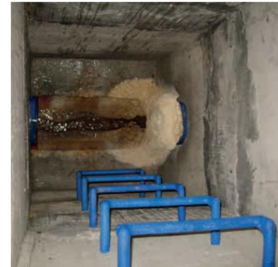
Abbildung 5 - Versinterung in einer Drainageleitung (Quelle: ÖBB)
