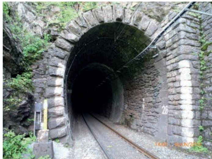
Abbildung 7 - Mauerwerkstunnel (Quelle: ÖBB)
