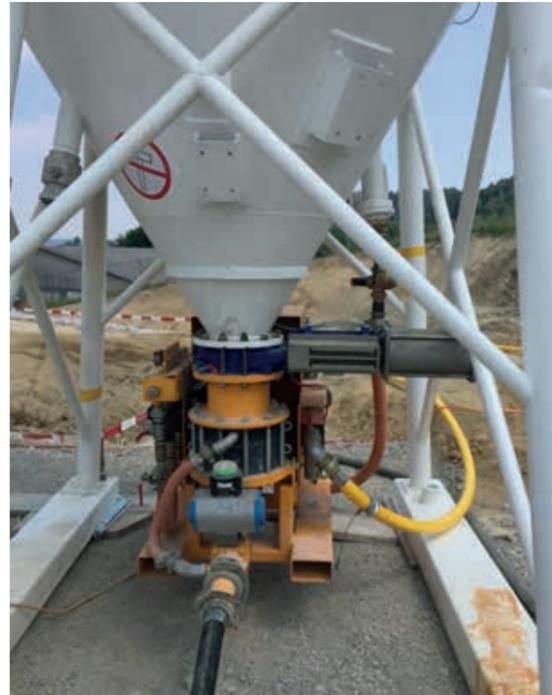
Aliva 272 – Betonkolbenpumpe auch mit Dosierpumpe synchro verbaut lieferbar. Förderleistung 4-20 m<sup>3</sup>/h, Korngößen Spritzen/ Fördern 16/32 mm
