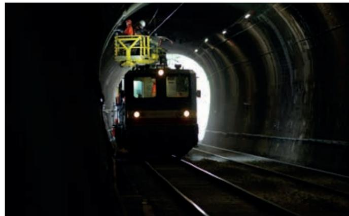
Abbildung 1 - Instandhaltung eines Eisenbahntunnels (Quelle: ÖBB)
